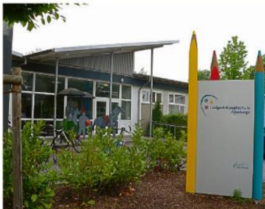
In die ehemalige Ludgeri-Hauptschule soll die neue Grundschule einziehen. Foto: mas
